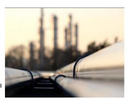
поперечного сечения, способу соединения и другим характеристикам. Например, по диаметру трубы делятся на малые (5-102 мм), средние (102-426 мм) и большие с диаметром от 426 мм.
